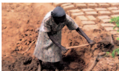
Kościół na południu Sudanu musi zaczynać od niczego: siostry Combonianki wyrabiają gliniane cegły do budowy domu.
